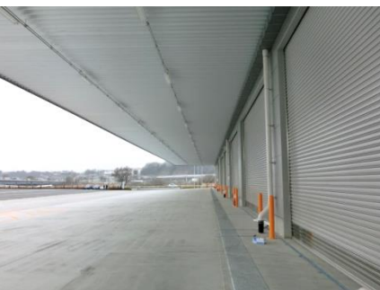
1F荷捌き底下
